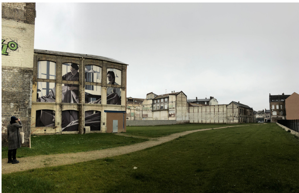
Figure 2 : Vue de la friche Cousin Corblin à Elbeuf
